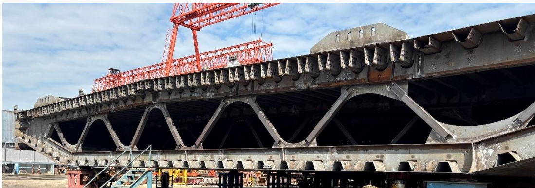
Figur 4 Tverrsnitt av stålkasse, fabrikasjon i Kina.
