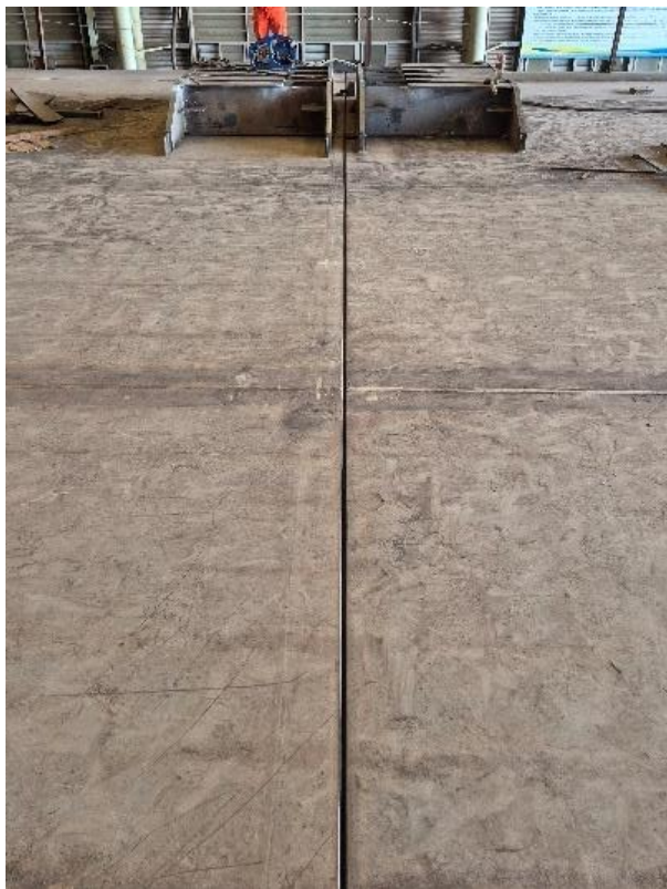
Figur 6 Eksempel på fuge mellom kasse-elementer som skal sveises på byggeplass i Norge. (Foto: Svv)
